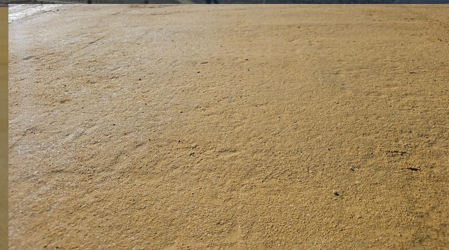
Compactación final · resultado homogéneo y estable
